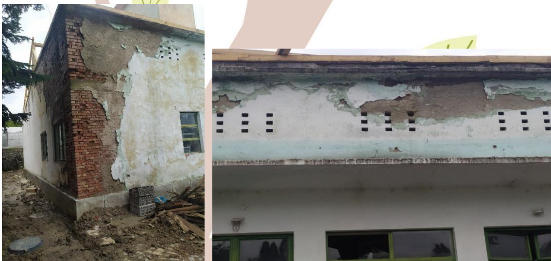
Foto 3 . Starea actuală a exteriorului clădirii Siloz fructe
