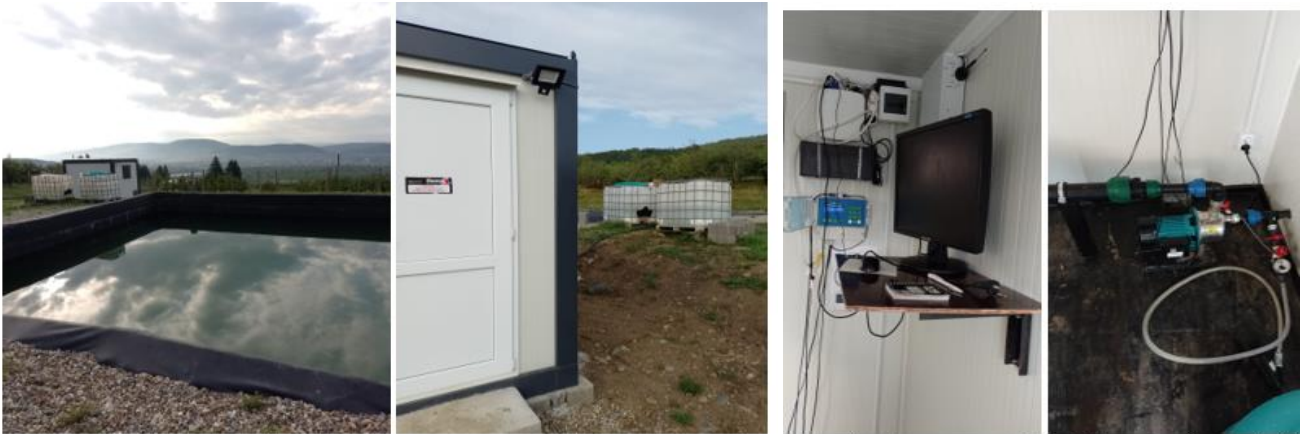
Figura. 18. Bazin cimentat căptușit cu folie EPDM de stocare apă, bazine tampon, echipament automatizare la sistemul de fertirigare
