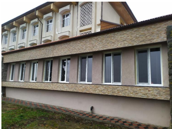
Figura 27. Reabilitarea și modernizarea parțială a fațadelor sediului SCDP Bistrița
